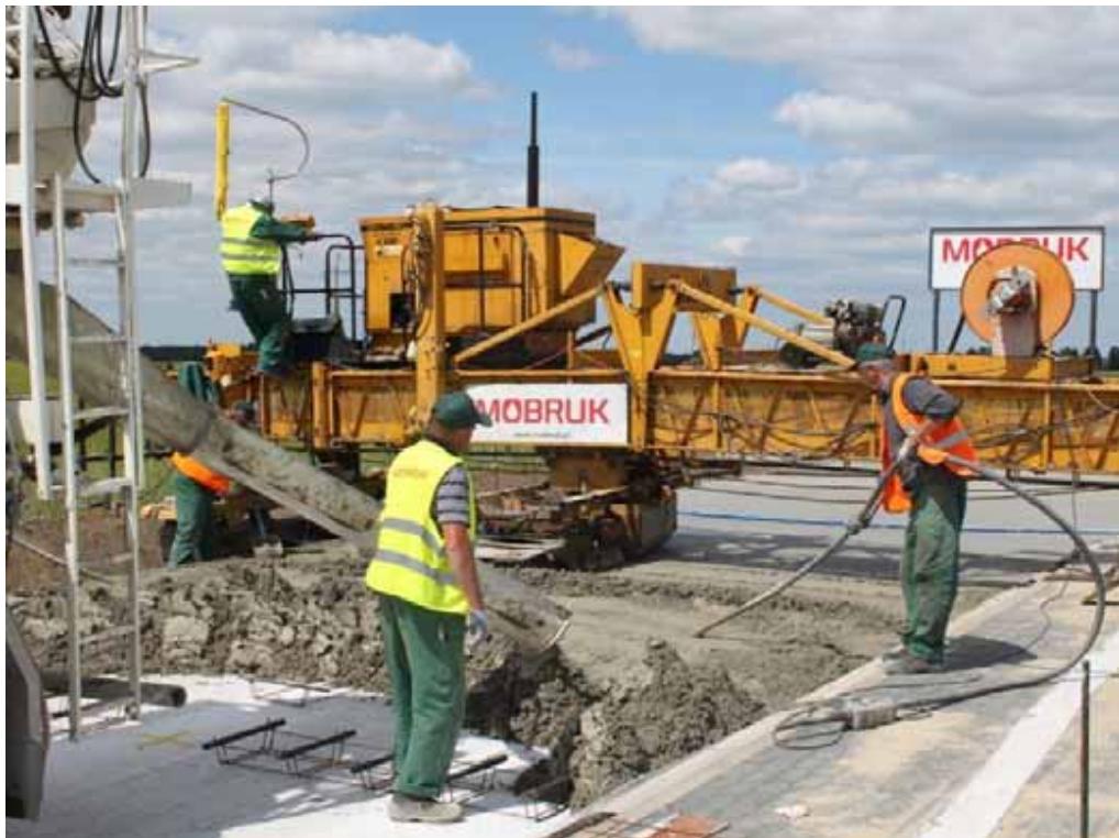
Rozkładanie betonu: układarką lub listwą wibracyjną
