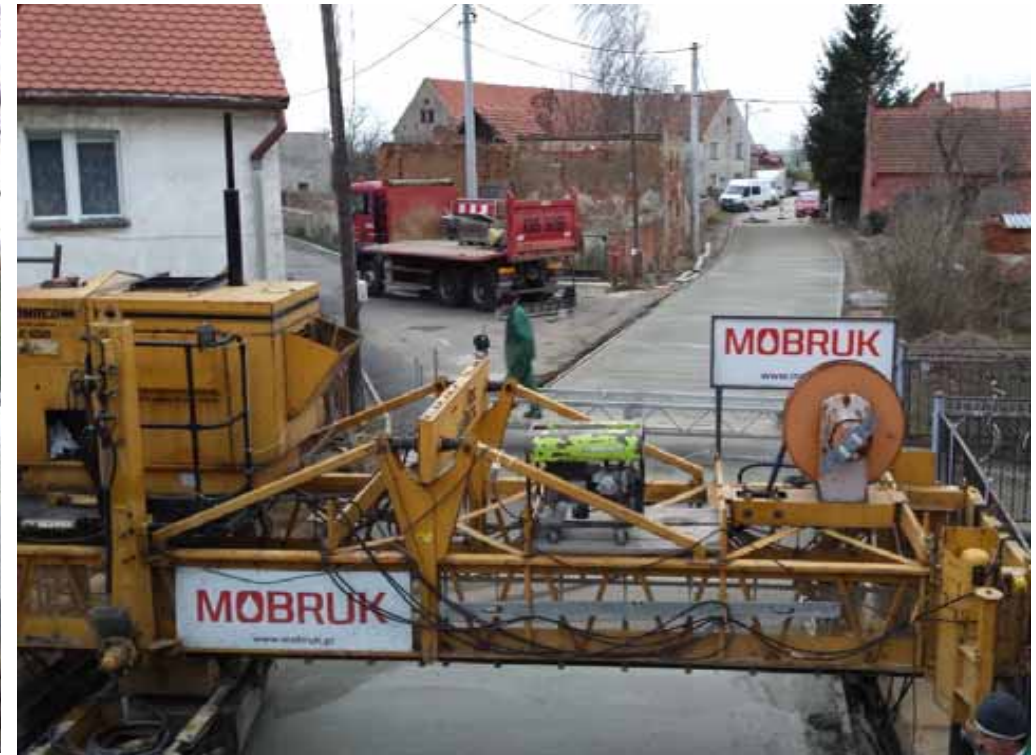
Układanie nawierzchni przy budynkach, ogrodzeniach
