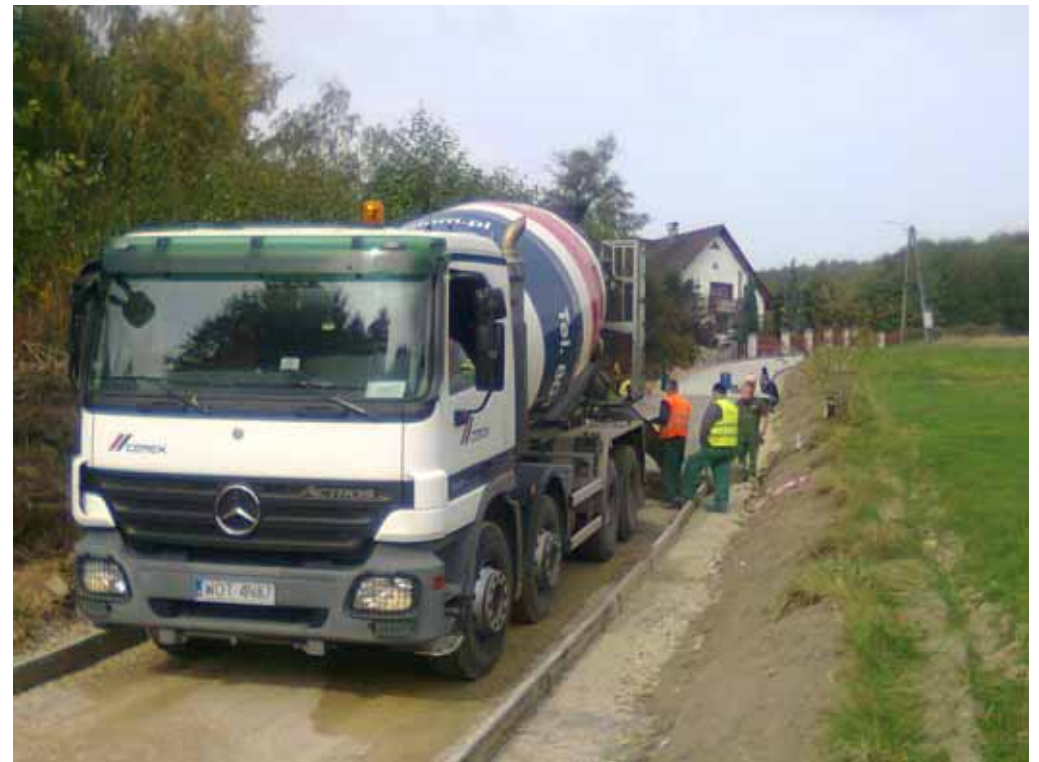
Rozkładanie betonu: układarką lub listwą wibracyjną
