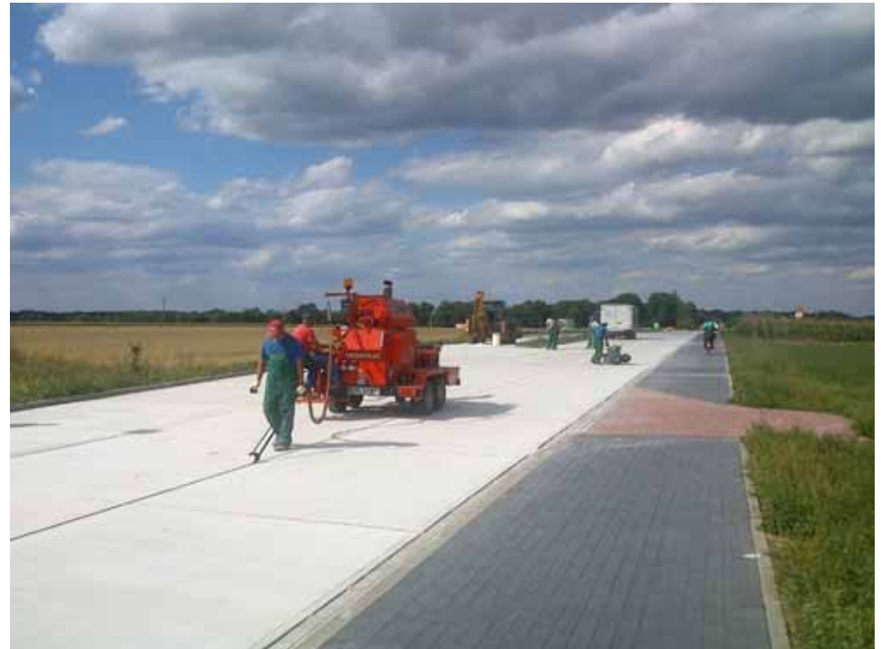
Wypełnianie szczelin dylatacyjnych masą zalewową
