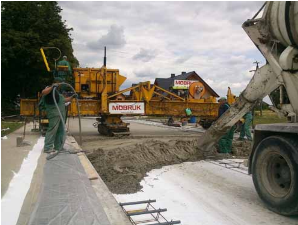
Układanie nawierzchni betonowej, dyblowanej
