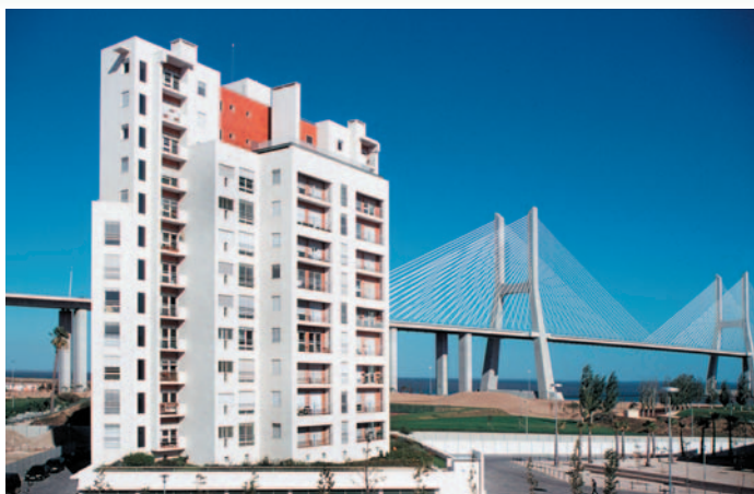
Rys. 5.4. Torre Verde (Zielona Wieża), efektywny energetycznie dwunastokondygnacyjny betonowy budynek mieszkalny (7200 m 2 ), zbudowany w Lizbonie, Portugalia. Monitoring pokazał, że emituje on około 24 tony CO 2 rocznie mniej, niż konwencjonalny budynek tej samej wielkości. Słoneczny system ciepłny dostarcza 70% ciepła do ogrzania ciepłej wody na potrzeby zużycia domowego w budynku. (Dzięki uprzejmości Tirone Nunes, SA, Portugalia)
