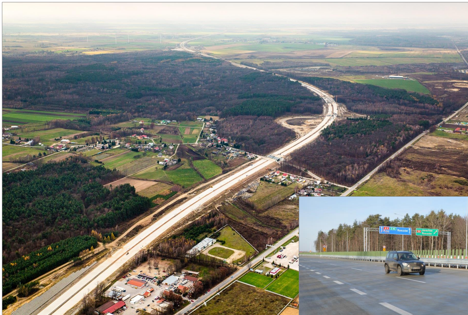
Autostrada A4 Radymno-Korczowa
