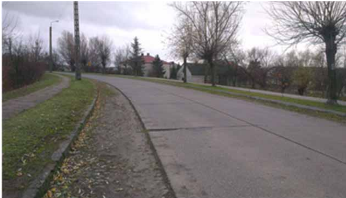
Widok nawierzchni betonowej w miejscowości Wilga po 55 latach eksploatacji Zdjęcie wykonane przez Wiesława Dąbrowskiego w dniu 11.11.2015
