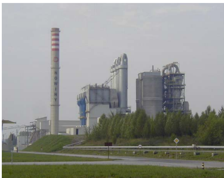
Cementownia Nowiny po modernizacji
